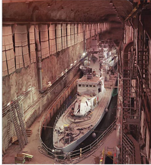
شکل ۱-۲- حفاظت از کشتی جنگی در تونل حفر شده در کوه
